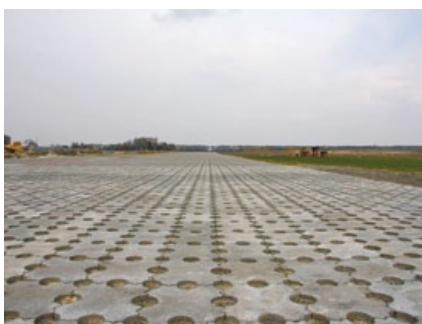
Полоса готова под засыпку грунтом и посев трав
