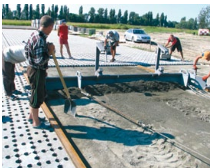
Подсыпка и выравнивание отсева
